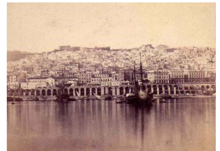
Collection Bibliothèque Nationale de France, Algiers, Construction du Boulevard de l'Impératrice 1863
